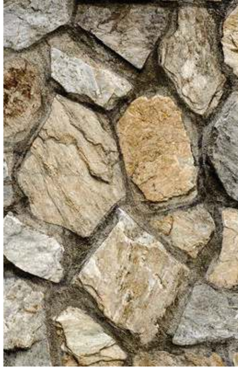
Taş duvar ÇV-DĞR05
